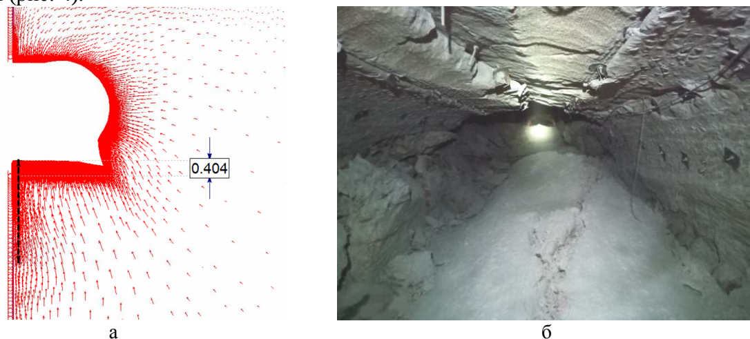
Рис. 4. Поле векторов смещений в окрестности одиночной горной выработки (а) и пример деформаций в выработке Гремячинского ГОКа (б)
