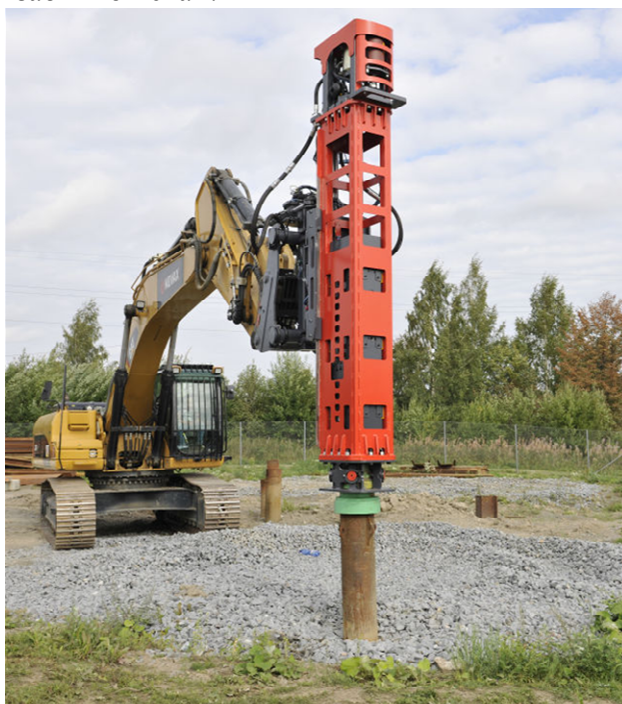
Рис. 1. Экскаватор со сменным рабочим оборудованием в виде сваебойного гидромолота
