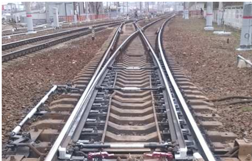
Рис. 1. Общий вид обыкновенного стрелочного перевода
