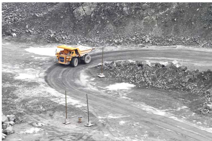
Рис. 1. Поворот технологической трассы на карьере «Северный» КачГОКа с малым радиусом
