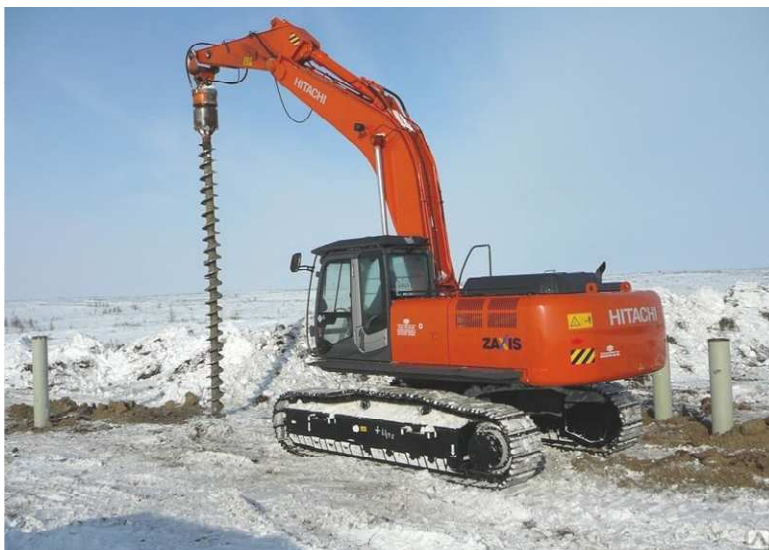
Рис. 1. Экскаватор Hitachi ZX 200 в процессе работы по закручиванию свай
