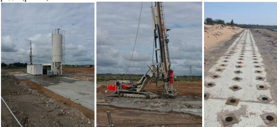
Рис. 1. Технология высоконапорной подачи раствора
