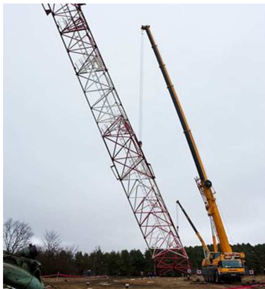
Рис. 1. Установка вышки сотовой связи
