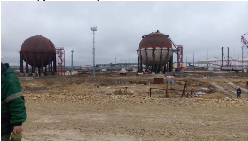
Рис. 1. Строительство шаровых емкостей для хранения сжиженного газа
