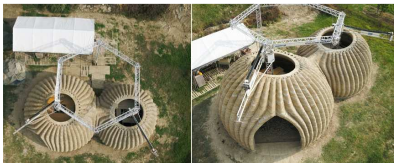
Рис. 1. Эко-жилой дом Tecla, напечатанный на 3D-принтере из глины
