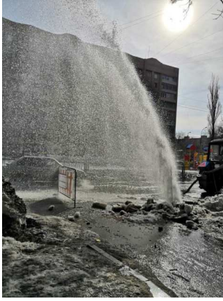
Рис. 2. Порывы трубопроводов
