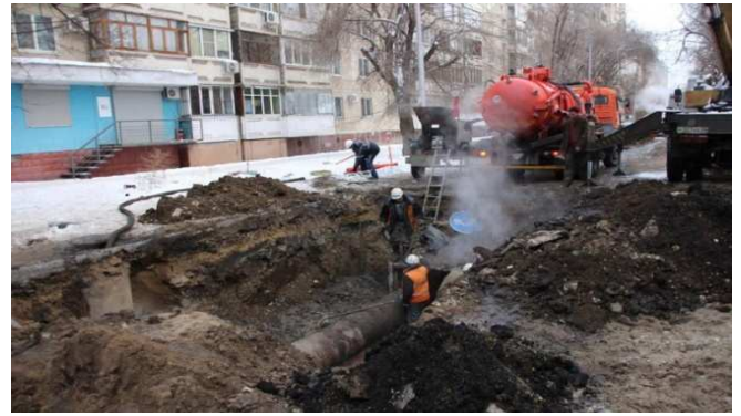
Рис. 3. Ремонтные работы в зимний сезон
