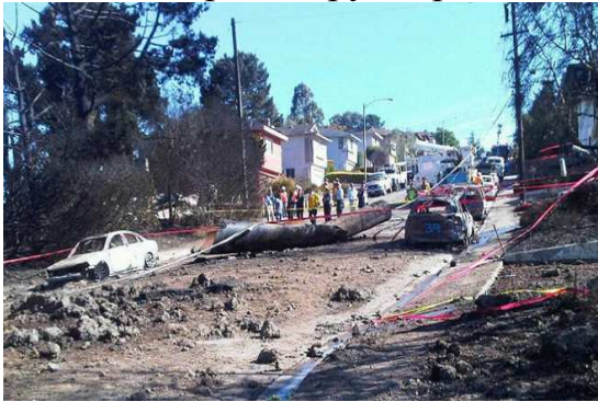
Рис. 4. Разрушение транспортных магистралей, порча транспортных средств
