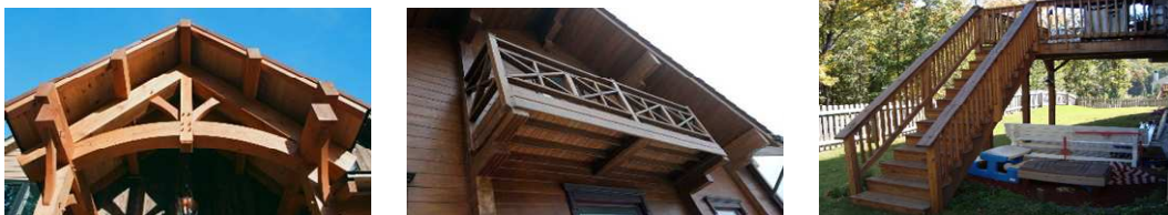
Рис. 1. Вынесенные конструктивные элементы деревянных домов
