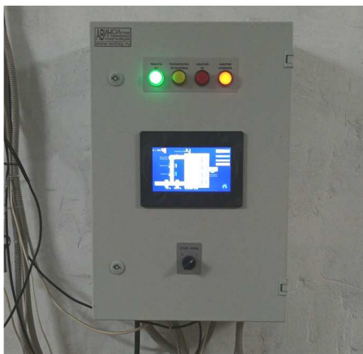
Рис. 4. Компьютеризованная система контроля климата в влагозащитном корпусе
