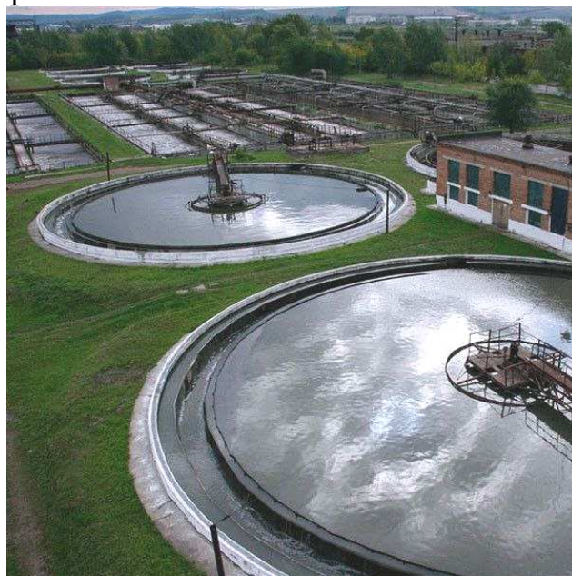
Рис. 2. Отстойники
