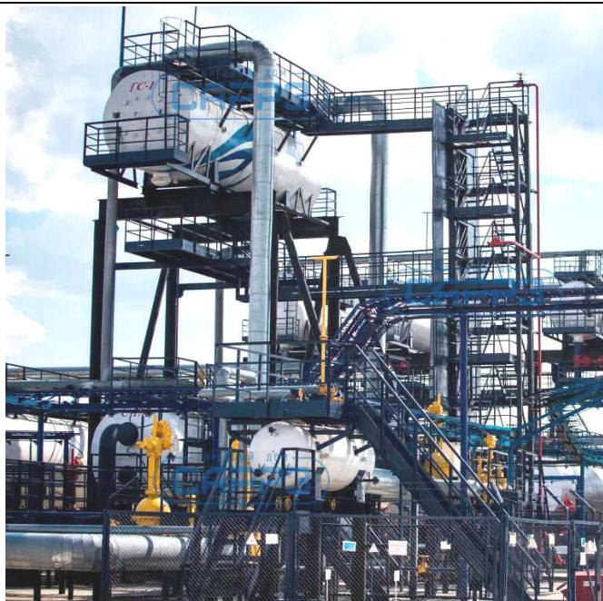
Рис. 3. Установка дополнительного оборудования
