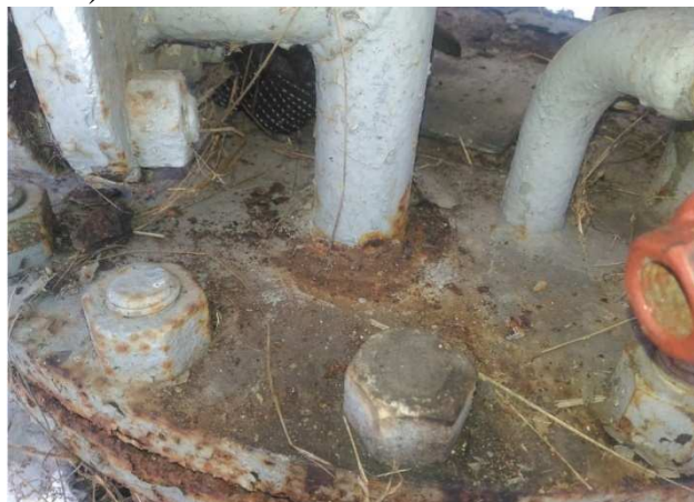
Рис. 5. РГ не прошла контроль по результатам УТ и ВИК
