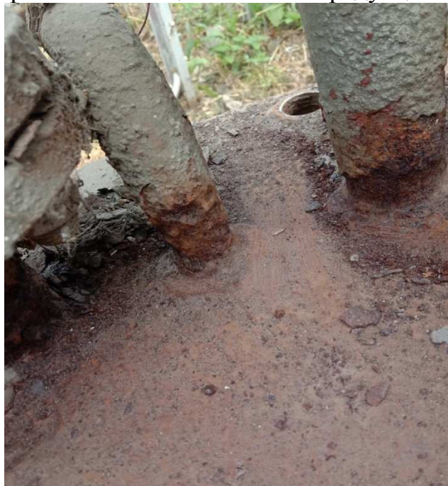
Рис. 6. РГ не прошла контроль по результатам УТ и ГИ
